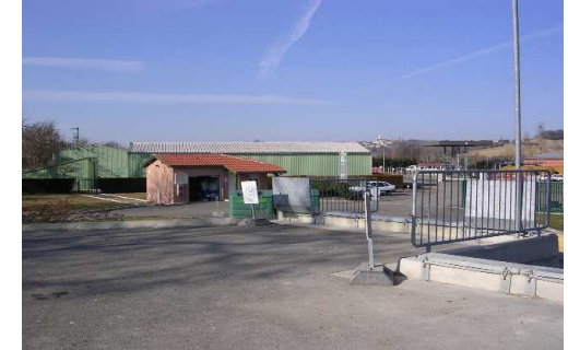
Lectoure (32700), Zone Industrielle
